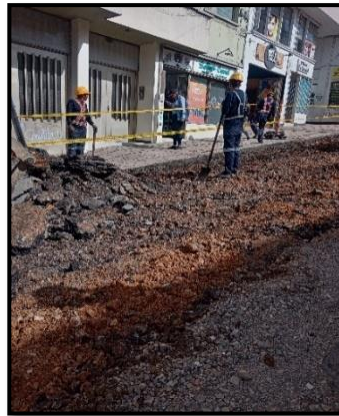
Ilustración 12. Levantamiento de capa asfáltica Fuente: Propia
