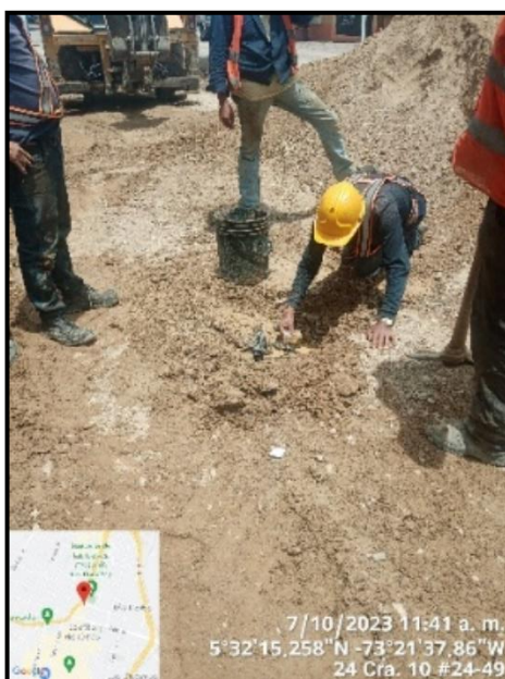
Ilustración 15 Reparación de conexiones domiciliarias
