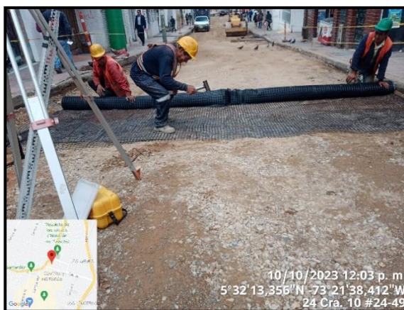
Ilustración 17. Instalación de Geomalla Bidireccional. Fuente: Propia.
