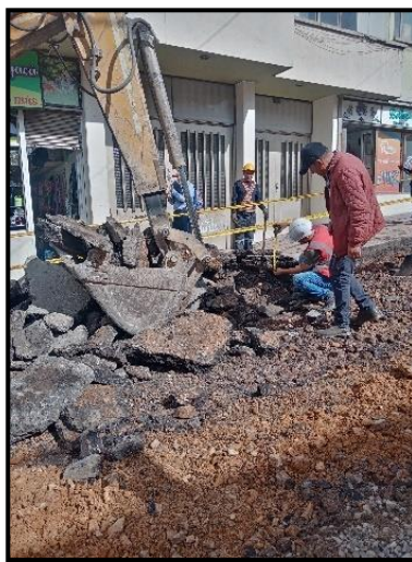
Ilustración 13. Retiro de escombros.
