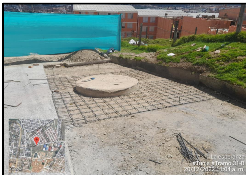
Figura 27. Reforzamiento de pozos
