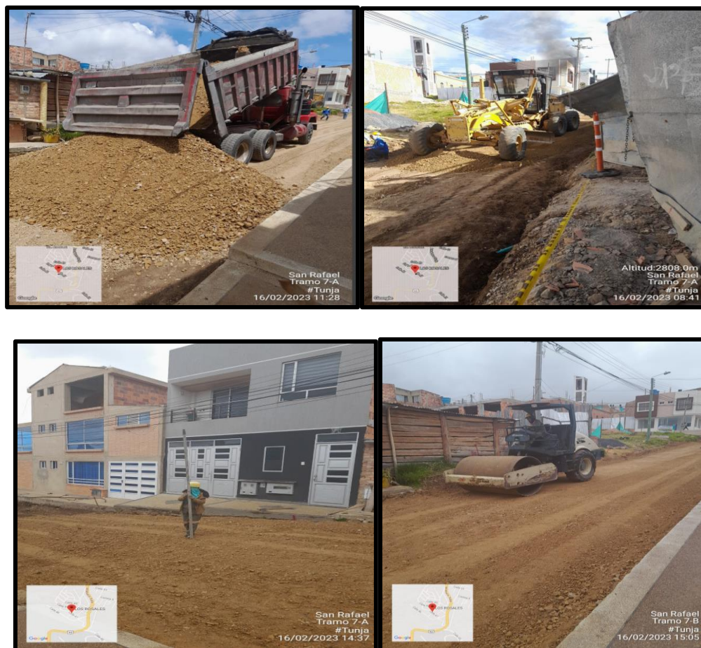
Figura 15. Registro de instalación, nivelación y compactación de mejoramiento sub base y base
