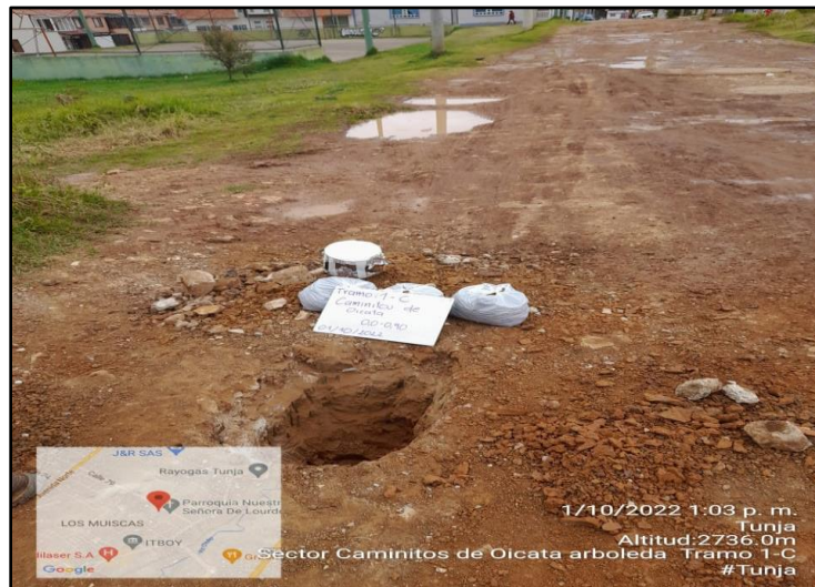
Figura 7. Apique y muestras ensayo de CBR Y PDC frente 1C
