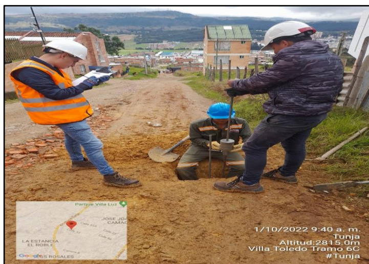
Figura 6. Apique y ensayo de CBR y PDC frente 6C
