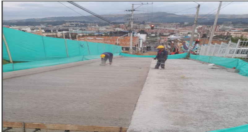
Figura 34. Corte y Sellado de Juntas transversales
