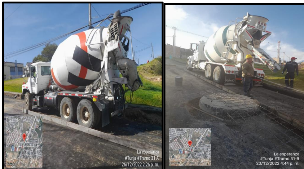
Figura 29. Suministro de concreto COLCONCRETO Y HOLCIM
