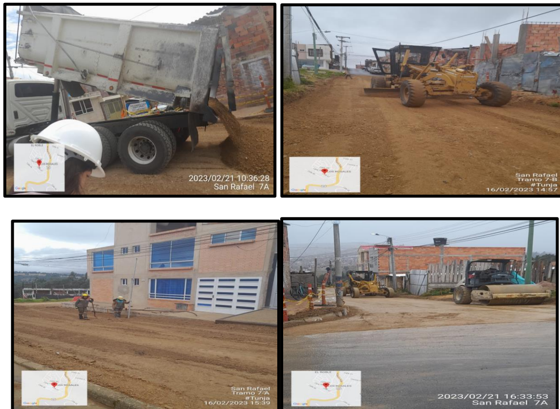
Figura 18. Registro de instalación, nivelación y compactación de mejoramiento base
