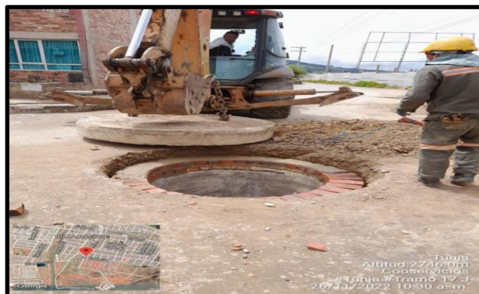
Figura 21. Izaje de tapa de pozo de inspección
