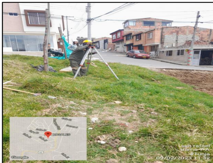
Figura 9. Replanteo en el frente San Rafael
