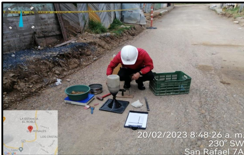
Figura 16. Toma de densidades capa Subbase
