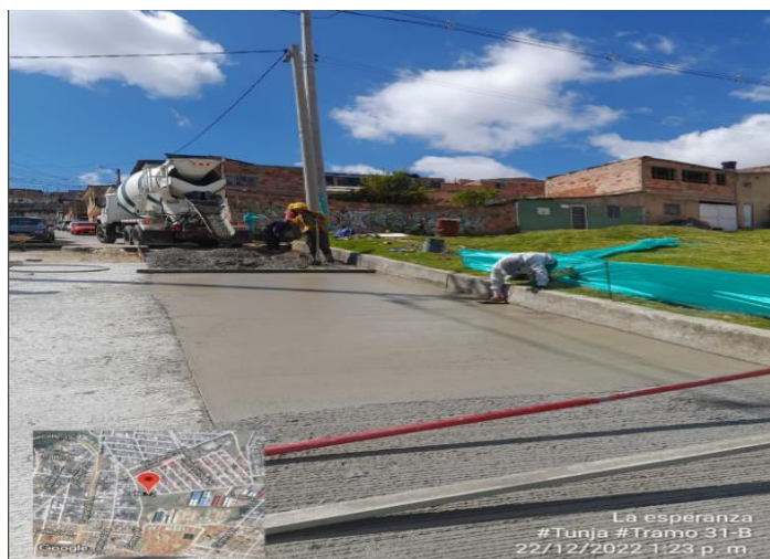
Figura 32. Nivelación y Cepillado del concreto
