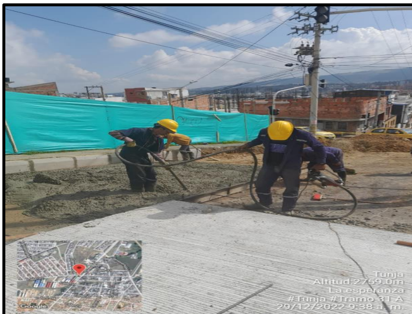
Figura 31. Vibrado de concreto
