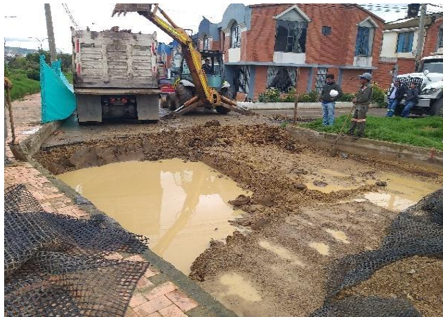
Figura 14. Retiro de fallo
