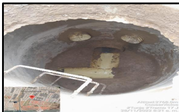
Figura 20. Re nivelación y limpieza de pozos de inspección
