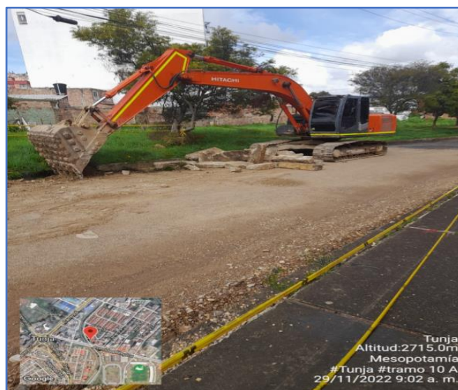
Figura 12. Excavación y retiro de material con Excavadora
