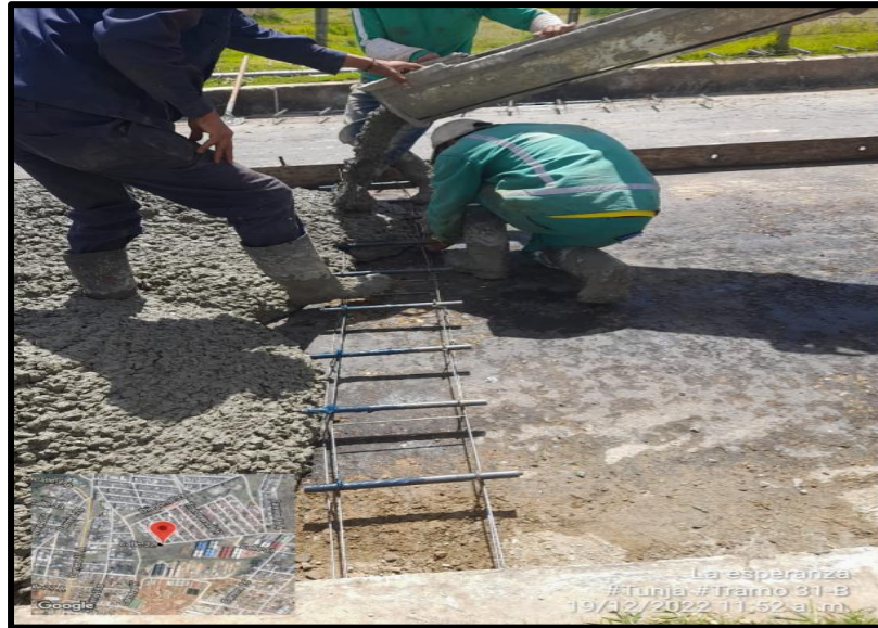
Figura 28. Instalación de dovelas
