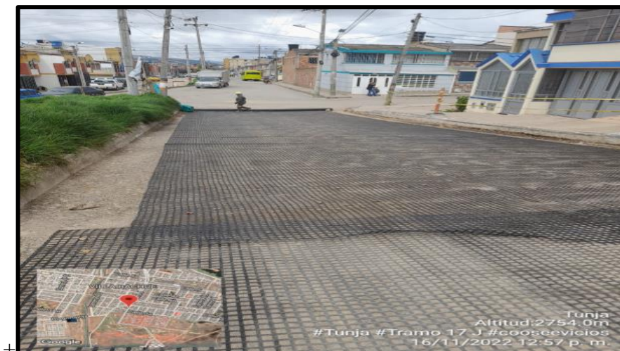
Figura 17. Instalación Geomalla
