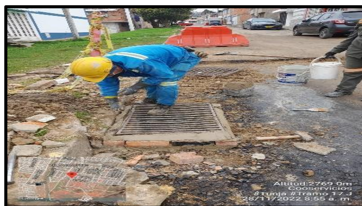
Figura 22. Re construcción de sumideros
