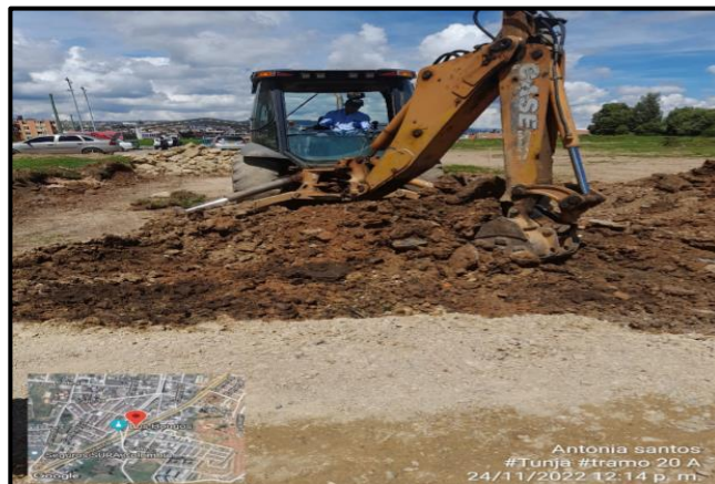
Figura 11. Excavación mecánica con Retroexcavadora
