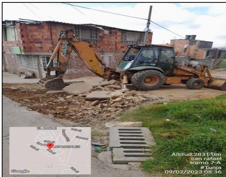
Figura 10. Demolición de concreto simple
