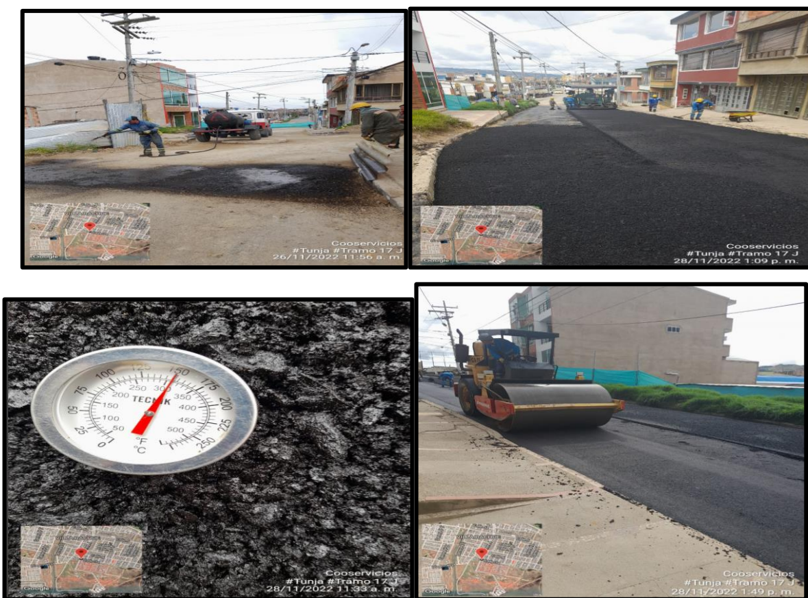
Figura 23. Instalación de carpeta asfáltica
